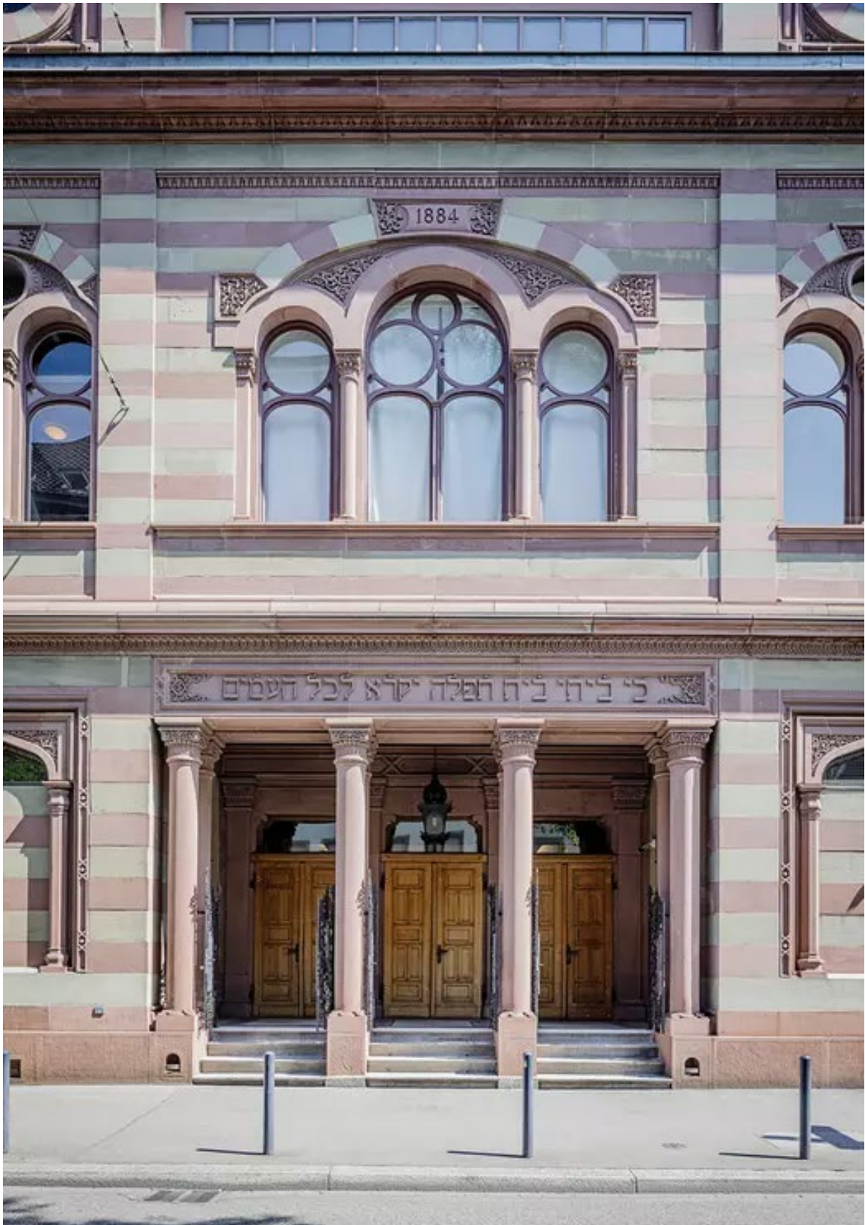
Das denkmalgeschützte und 2022 aufwändig instand gestellte Eingangsportal der Synagoge Löwenstrasse zeigt sich in neuer alter Pracht.
